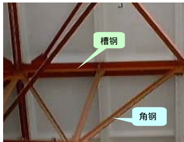
图 2 槽钢在大型屋顶钢结构中的应用
