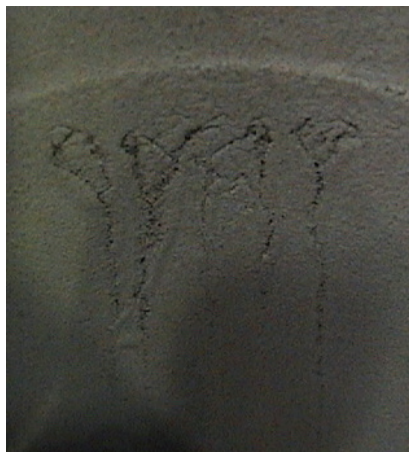
图 1 缸体水套砂芯上的涂料破水缺陷
