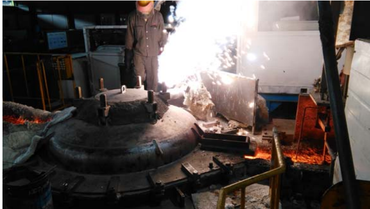
图 5 清理氮气管孔内堵渣的过程图
